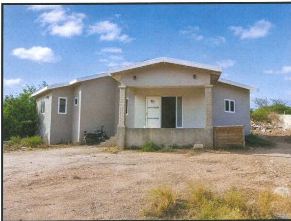
Voorraanzicht van de woning te San Fuego 38-A.
